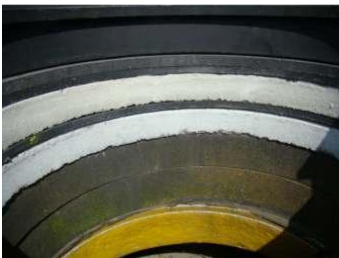
foto 1. Štruktúra záhlavia šachty založená na striedaní plastových a betónových vyrovnávacích prstencov bez použitia cementových mált. Tesniaci a spájací materiál je univerzálny trvale pružný polymérový tmel. Nastavenie výšky záhlavia šachty je 35 cm.
