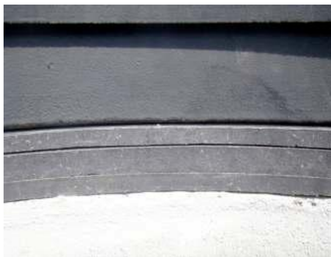
foto 2. Štandardné použitie prstencov systému TVR T na betónovom vrchnom diele šachty pre nastavenie výšky a sklonu poklopu s funkciou absorbéra tlaku. Vyrovnávacie prstence o výške 15,30,40mm a šikmé vyrovnávacie prstence T1K600/9/22, T1K625/9/22 a T1K63530/60mm eliminujú používanie nespoľahlivých cementových hmôt v konštrukcii a umožňujú prispôsobiť sklon poklopu k sklonu vozovky.
